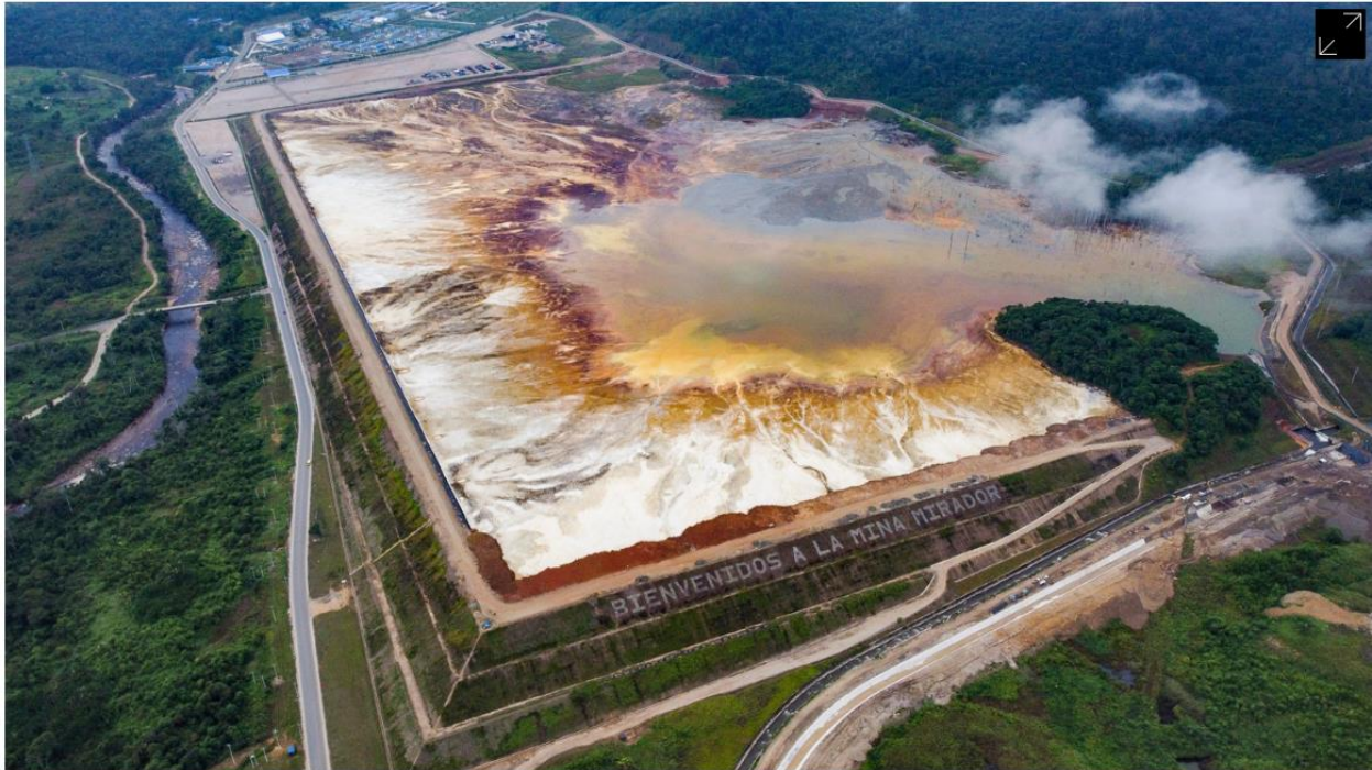
La relavera Quimi fue construida al borde del río con ese mismo nombre. La escombrera tiene una altura de aproximadamente 30 metros. Fotos: Luis Argüello. PlanV
